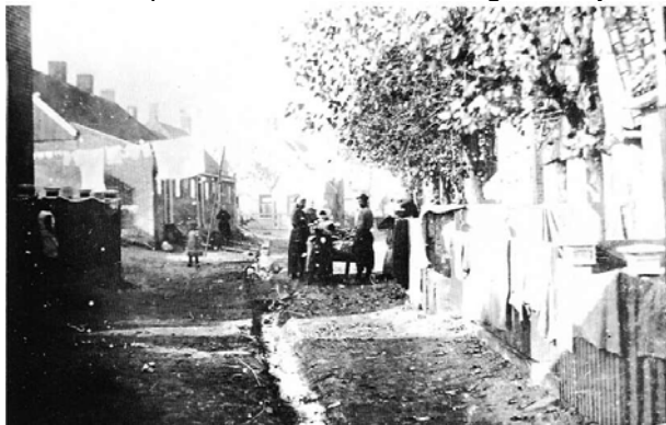
fig. 10: het straatbeeld vóór de aanleg van riolering en bestrating
