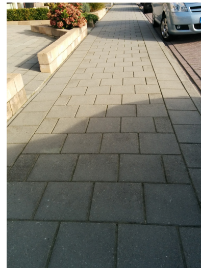
Detail 6 trottoir Aan beide kanten een strek toepassen
