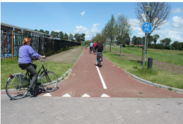
Asfalt fietspad t.h.v. Zwolsebrug
