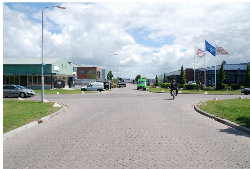
Rijbaan, kruising bedrijventerrein, bochtbescherming.
