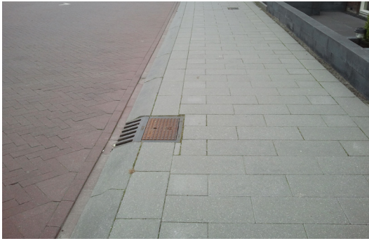
Trottoir Uitgevoerd met betontegels 42,2 x 21 x 8 en 5/20 trottoirband
