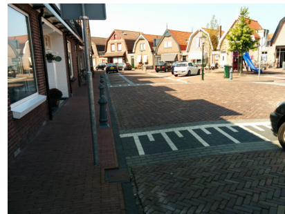
Algemeen straatbeeld Oude Dorp met hoogteverschil trottoir Rijbaan, trottoirs, plateau, parkeren, openbare verlichting, afzetpalen
