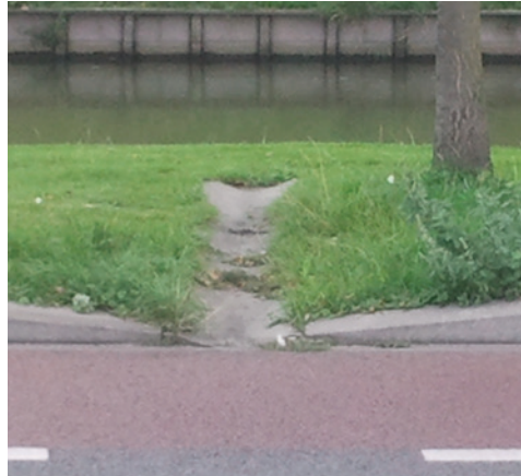
Afkoppelen wegen Bij wegen naast watergangen. Plaatselijk verlaagde trottoirband in combinatie met betonnen goot voor afvoer richting watergang.
