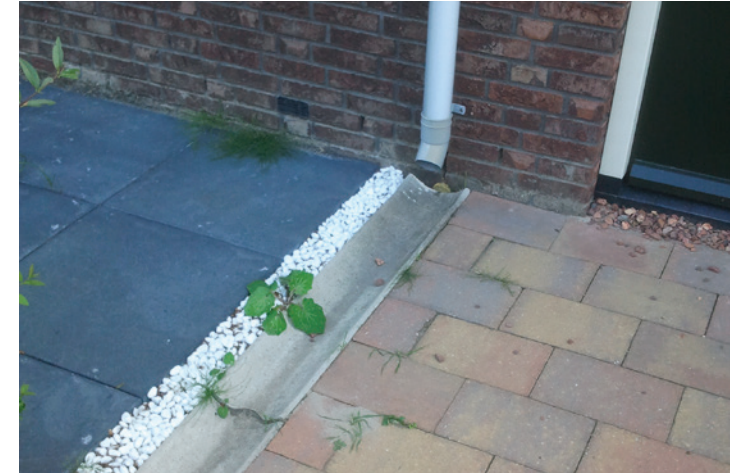
Afkoppelen woningen Door middel van oppervlak afvoer; voorkomt foutieve aansluitingen en scheelt extra aansluiting in de ondergrond. Afkoppeling voorzien van afkoppelblok en smalgootje
