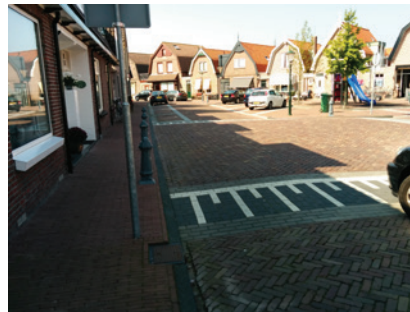
Algemeen straatbeeld Oude Dorp met hoogteverschil trottoir Rijbaan, trottoirs, plateau, parkeren, openbare verlichting, afzetpalen
