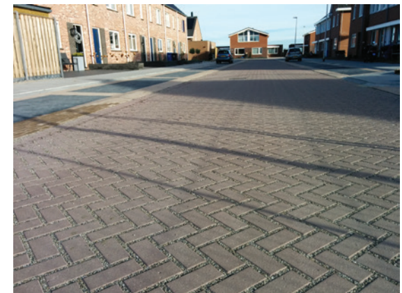
Waterpasserende verharding betonstraatstenen
