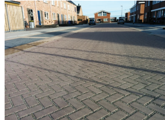
Waterpasserende verharding betonstraatstenen
