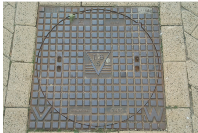
Inspectieputten DWA Putranden toepassen met opschrift VW. Bij voorkeur merk TBS
