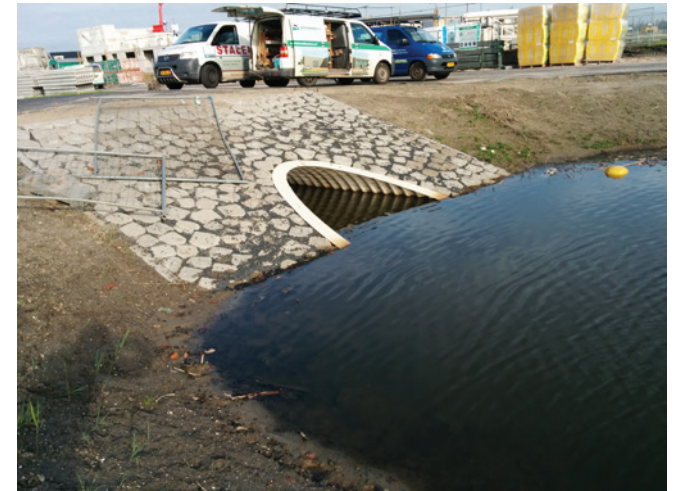
Multiplate duiker in dam afwerken met betonnen oeverbescherming
