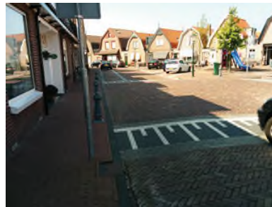
Algemeen straatbeeld Oude Dorp met hoogteverschil trottoir Rijbaan, trottoirs, plateau, parkeren, openbare verlichting, afzetpalen
