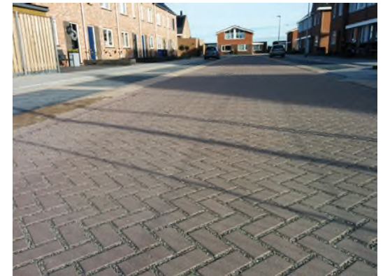
Waterpasserende verharding betonstraatstenen
