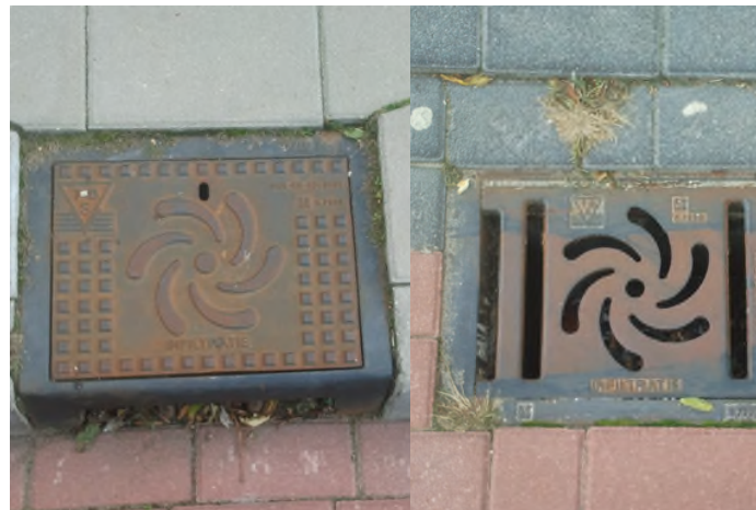
Waaiermotief In gebieden waar afgekoppeld wordt of een gescheiden stelsel is, worden trottoir- of straatkolken toegepast met waaiermotief
