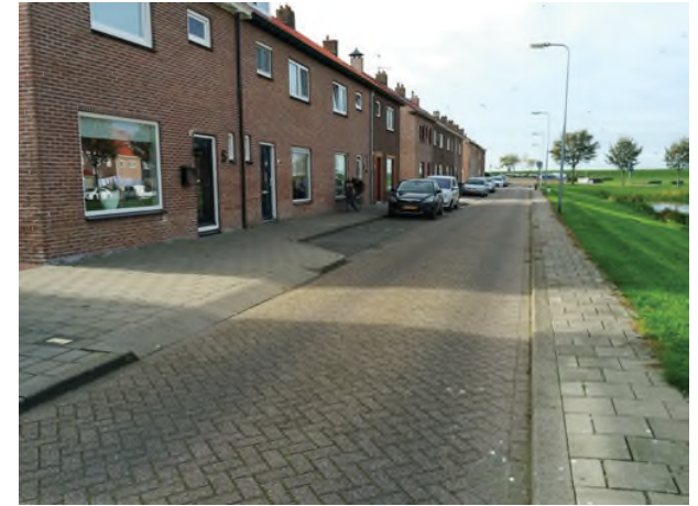
Algemeen straatbeeld wonen voor 2000 Rijbaan, parkeren, trottoir, inrit
