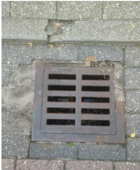
Straatkolk BS-STR 9736 Indien mogelijk werken met trottoirkolken. Alleen toepassen in molgoten
