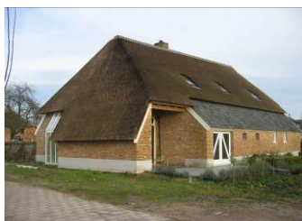
Nieuwe woning ter plaatse van de voormalige schuur aan de Ruffelsdijk
