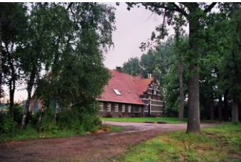
Monumentaal hoofdgebouw De Hagert
