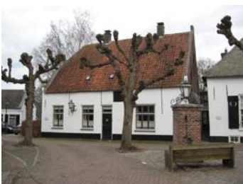
Kerkstraat 9 aan het pleintje met de pomp
