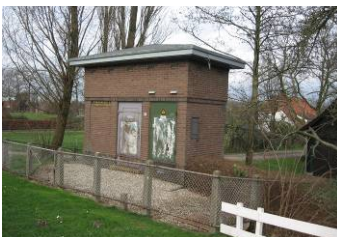
Trafo aan de de Molendijk
