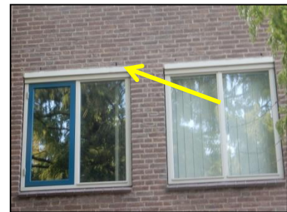
Figuur 27. Open stootvoegen in voormalige gemeentekantoor.
