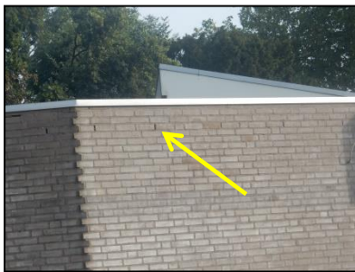
Figuur 25. Open stootvoegen uitvaartcentrum.
