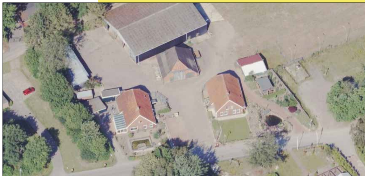
de bestaande boerderijen met daarachter de te slopen opstallen
