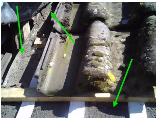
Foto 13. Niet-asbesthoudend dakleer Kruisakkers 18
