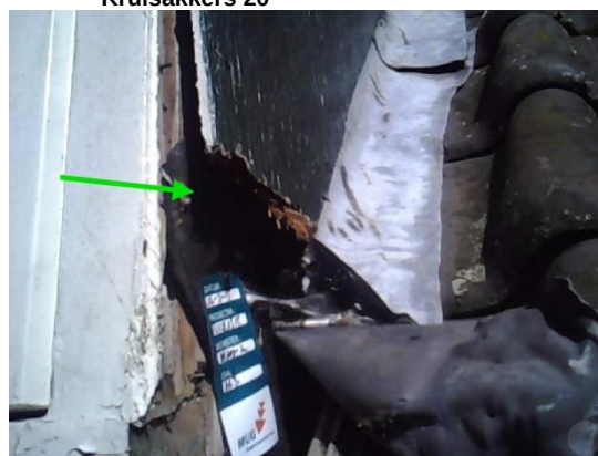
Foto 10. Niet-asbesthoudend dakleer Kruisakkers 20
