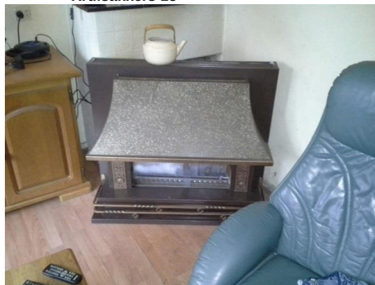
Foto 24. Asbesthoudende gashaard Kruisakkers 20a
