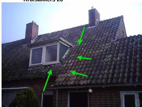
Foto 9. Niet-asbesthoudend dakleer Kruisakkers 20
