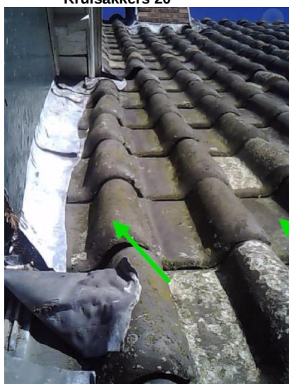
Foto 11. Niet-asbesthoudend dakleer Kruisakkers 20
