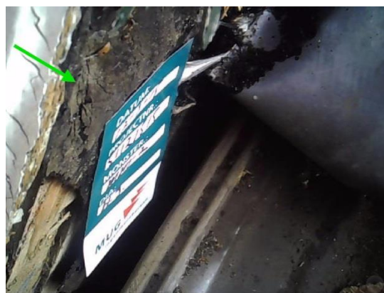
Foto 8. Niet-asbesthoudend dakleer Kruisakkers 20
