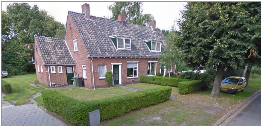
Huizen die op dit moment gesitueerd zijn op de planlocatie, en die in het kader van het woningbouwplan worden gesloopt.
