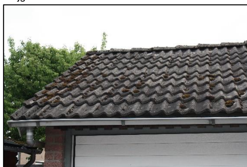
Foto 6. Dak van bijgebouwen
