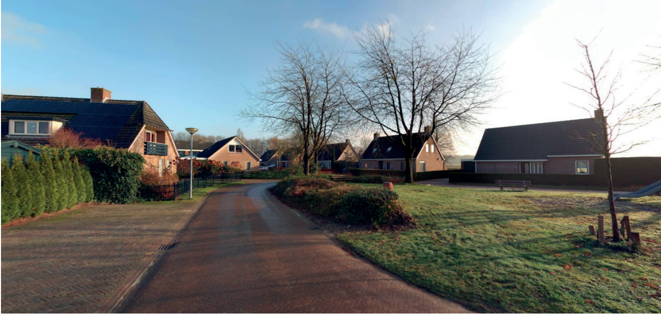
beeld bestaande woningen ten noorden plangebied
