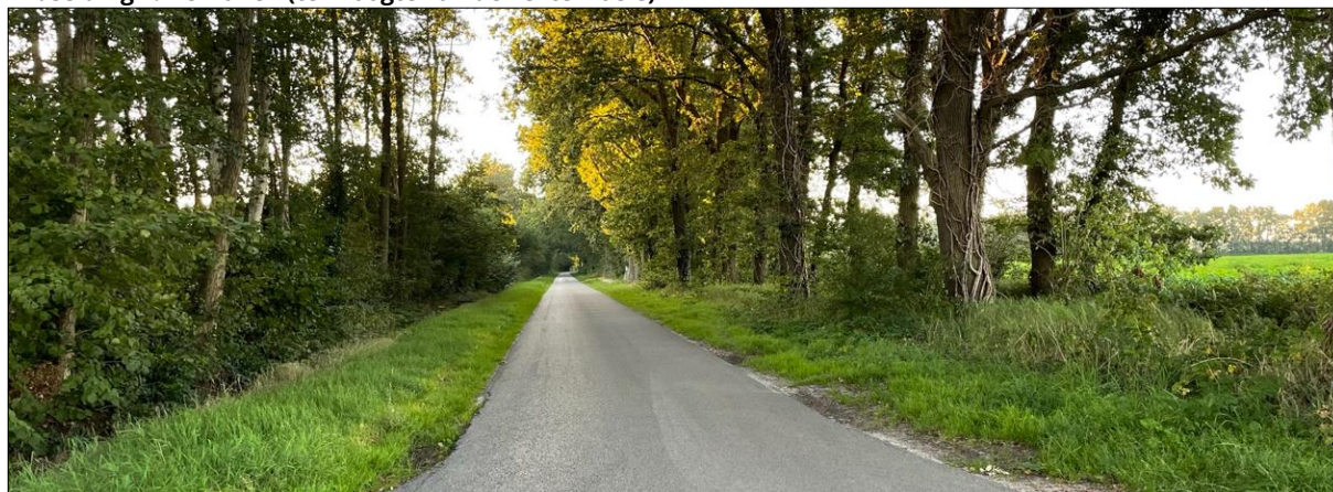
Afbeelding 2: De Hullen (ter hoogte van de Eexterkoele)
