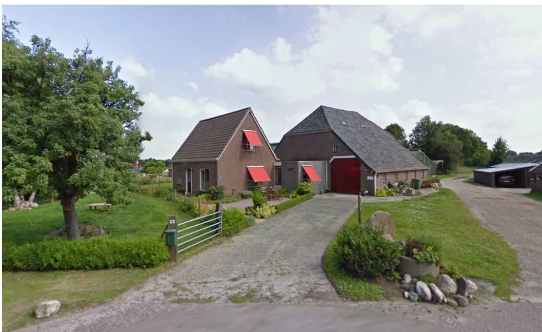
Bestaande situatie Eldersloo 5, gezien vanaf de weg Eldersloo (bron: Google Streetview)
