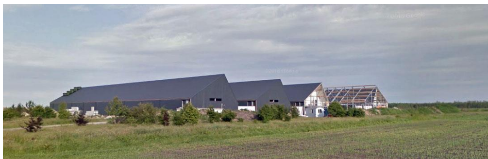
Afbeelding 2: De bedrijfsbebouwing tijdens de bouw.
