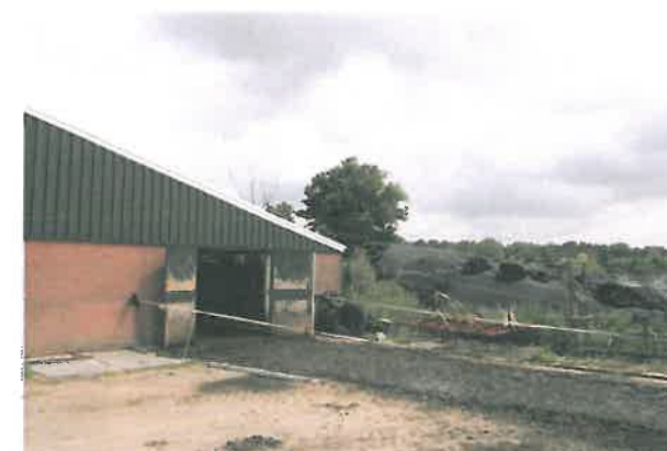
Het erf Rond de schuren zijn een groot aantal opslagkuilen gesitueerd.
