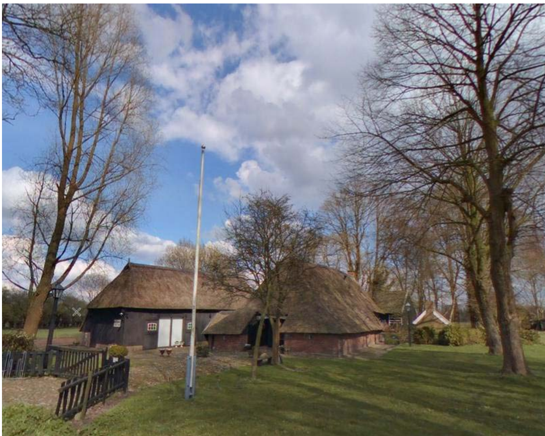
De Bonne 2, erf en bebouwing voor de brand. Witte deuren zijn niet conform de vergunning van 1989.
