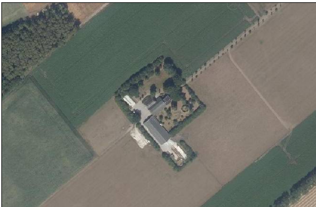
Luchtfoto bestaande situatie agrarisch bedrijfsperceel Hoofdstraat 42 (bron: PDOK)
