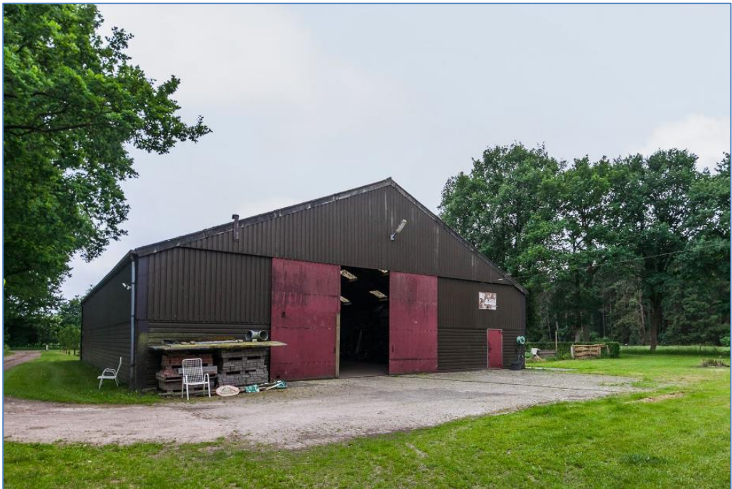
Figuur 2.4: Achterzijde van de aangebouwde schuurdeel, achter de voormalige bedrijfswoning
