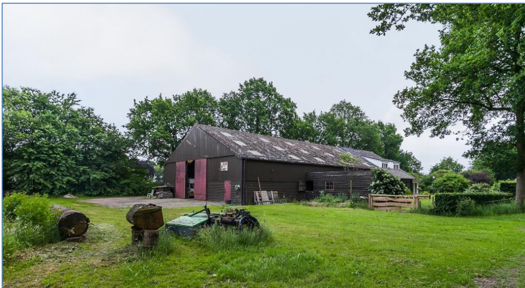
Figuur 2.5: Aanzicht van de aangebouwde schuurdeel met de voormalige bedrijfswoning. Rechts de tuin van de woning met bijbehorende bebouwing zoals een overkapping/prieeel
