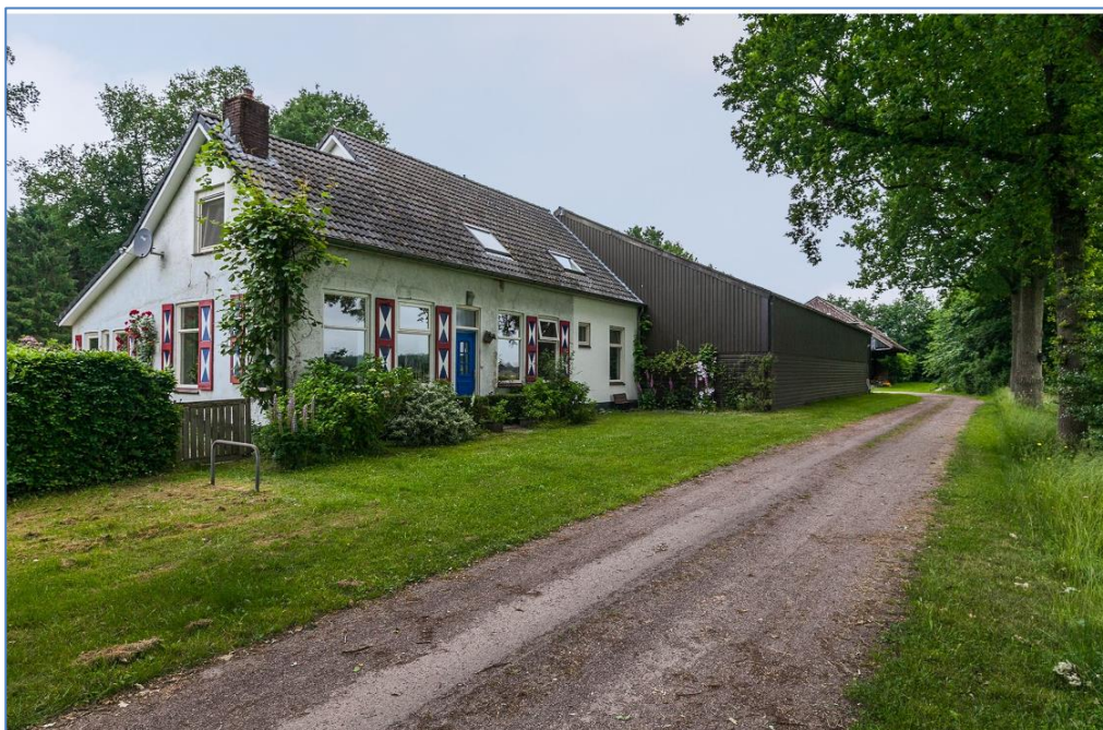
Figuur 2.3: Een aanblik van de voormalige bedrijfswoning met daarachter een aangebouwde schuurdeel.
