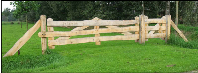
Figuur 18 Kastanjehouten landhek
