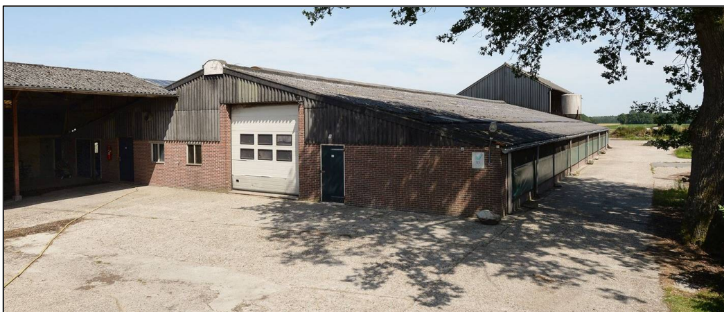
De inmiddels gesloopte voormalige agrarische bedrijfsgebouwen (bron: Funda)
