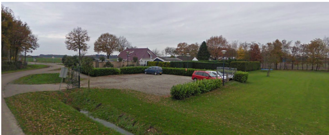
Bestaande situatie Rolderstraat 8, gezien vanaf de Hoge Veldweg (bron: Google Streetview)
