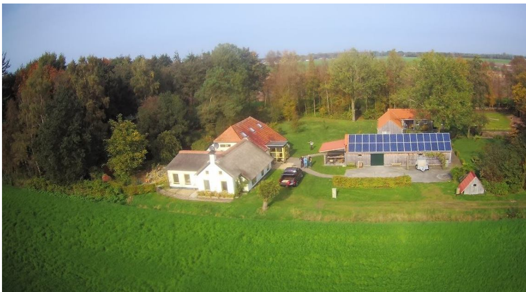
Bebouwing zorgboerderij in het plangebied (bron: Carefield Zorg)
