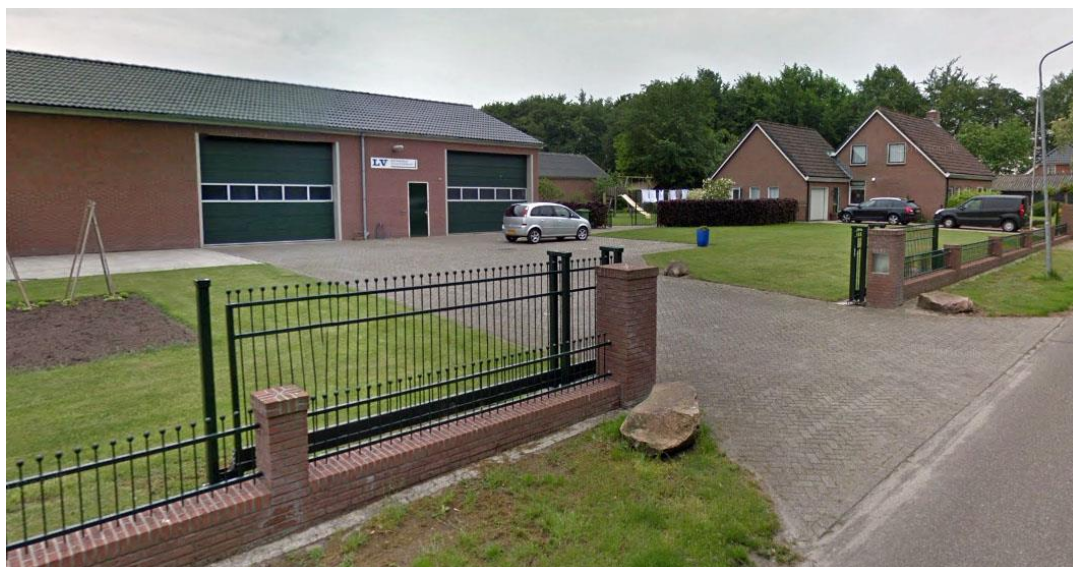
Afbeelding 2: De huidige bedrijfsbebouwing op het perceel Verlengde Grensweg 2.
