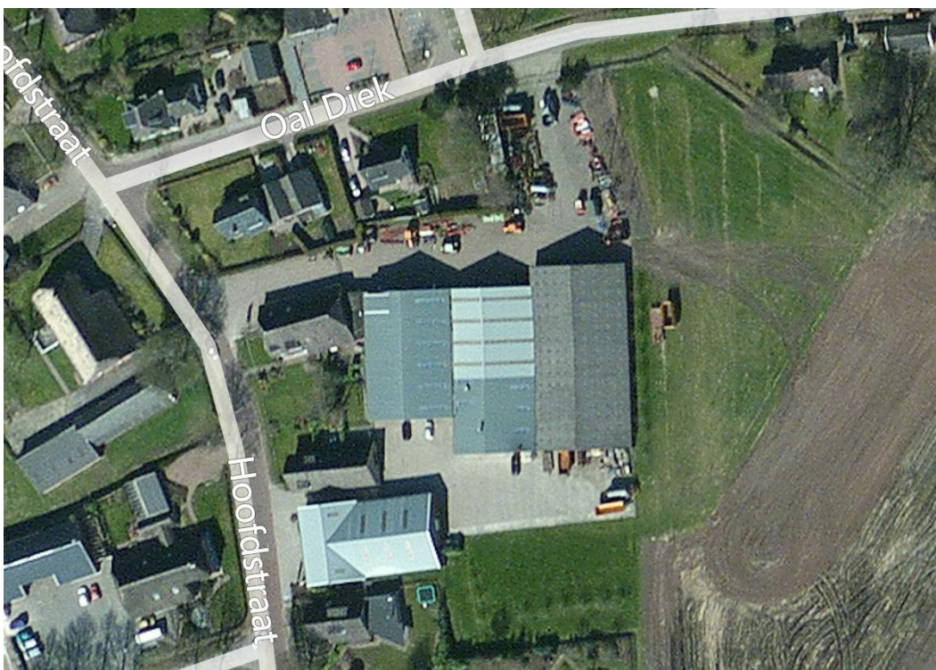
Luchtfoto bestaande situatie plangebied (bron: Bingmaps)
