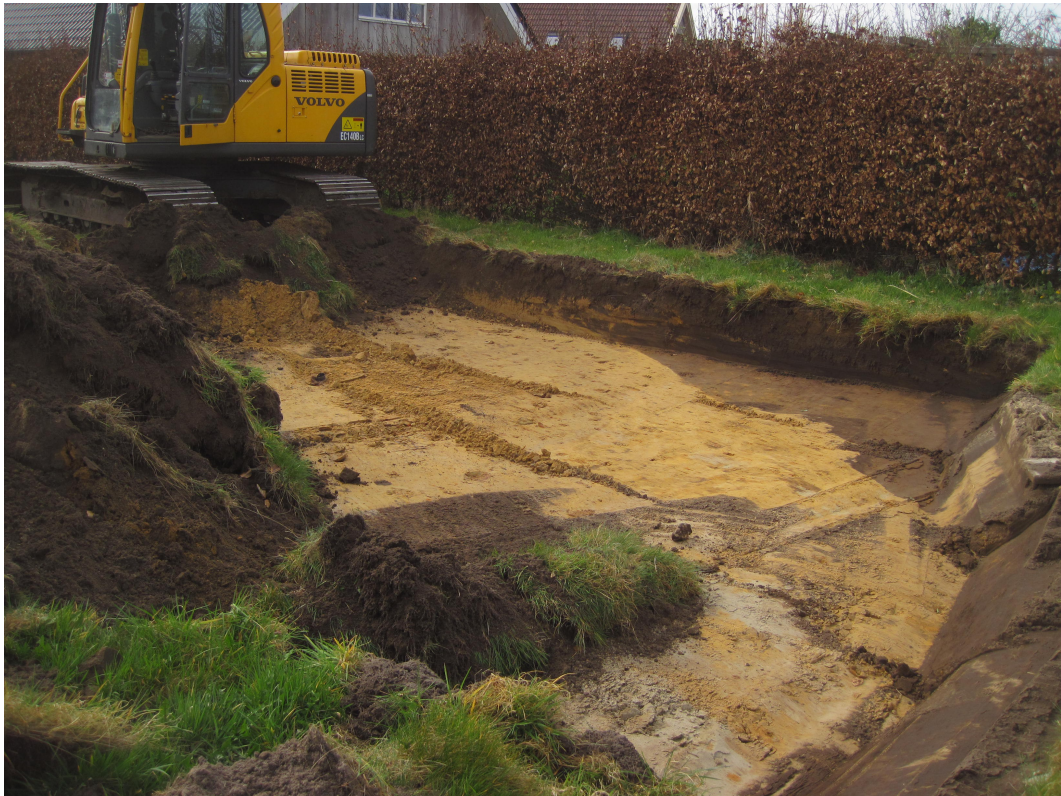
Figuur 12. Eext, Vesselkampen: foto van het vlak in werkput 5. Vanwege de verstoringen in deze werkput en omdat de put op een rioolleiding lag is de put niet verder uitgegraven dan de eerste 5 meter. Werkput 4 is met de resterende meters verlengd.
