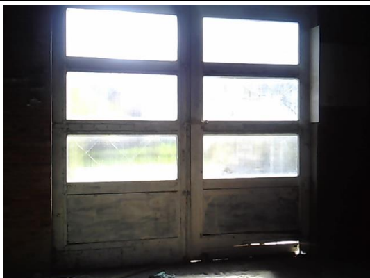
Kozijnen in zithoek tussen schuur 1 en afdak, geen verdachte materialen aangetroffen
