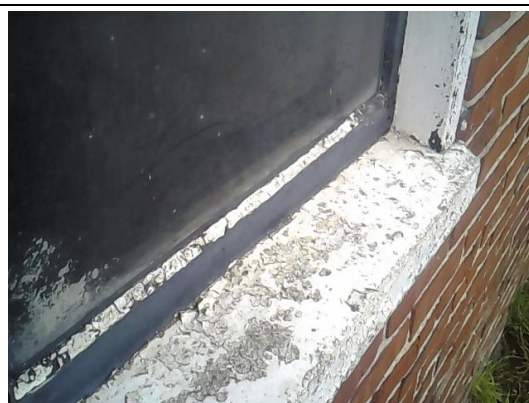
Kozijnen in buitengevel van schuur 1 met stopverf, niet verdacht
