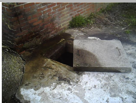
Inspectie van de waterput naast schuur 1, geen verdachte materialen aangetroffen
