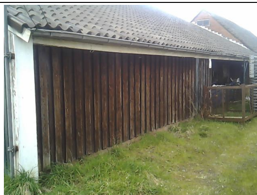
Inspectie van het maaiveld ter plaatse van de garage, geen verdachte materialen aangetroffen
