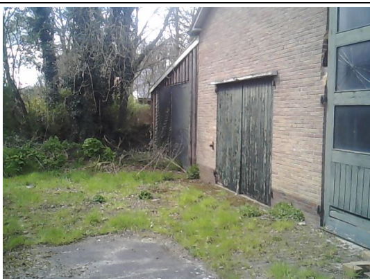
Inspectie van het maaiveld aan de achterzijde van schuur 2 en aanbouw, geen verdachte materialen aangetroffen
