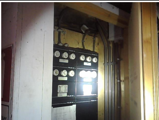
Inspectie in de meterkast in schuur 1, geen verdachte materialen aangetroffen
