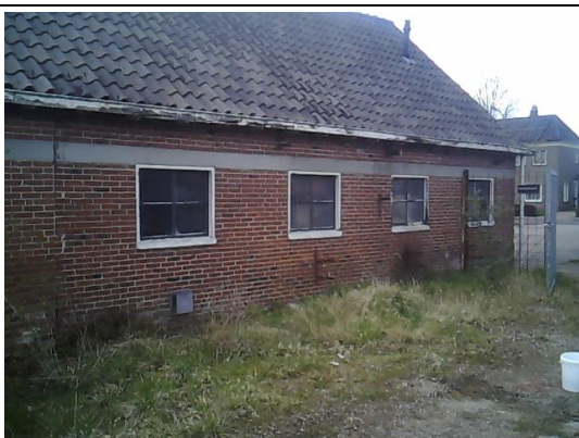
Kozijnen in buitengevel van schuur 1 met zachte beglazingskit of stopverf, niet verdacht
