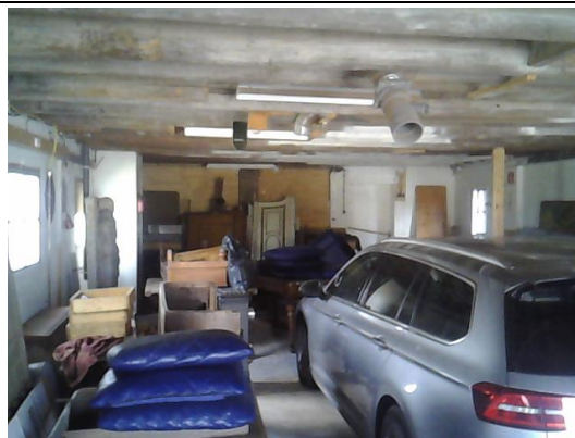
Inspectie aan binnenzijde van schuur 1, geen verdachte materialen aangetroffen
