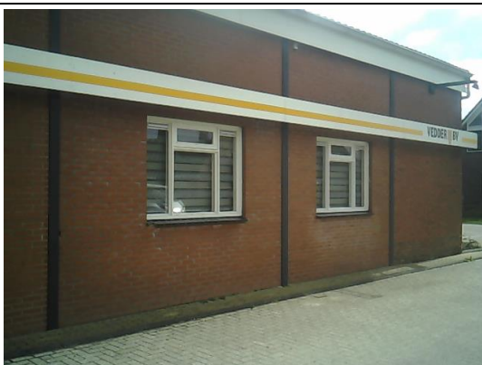
De kozijnen van het kantoorgedeelte zijn nieuw geplaatst met dubbelglas, niet verdacht
