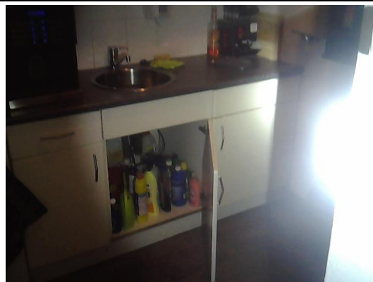
Inspectie achter keukenblok, geen verdachte materialen aangetroffen
