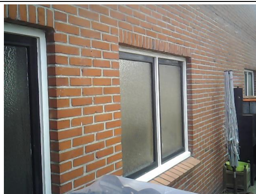
Inspectie van de buitengevels, geen verdachte materialen aangetroffen
