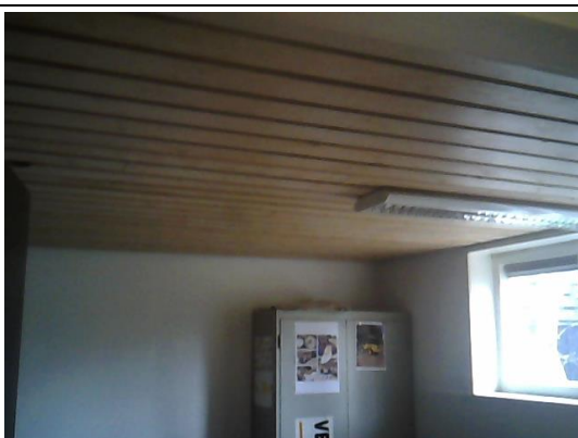
Plafonds in kantoren, niet verdacht
