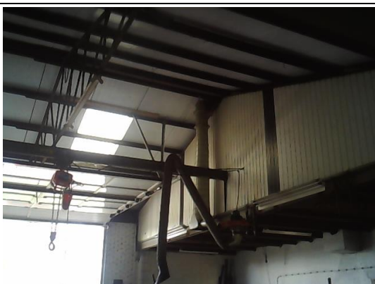
Dakconstructie met nieuwe damwand dakplaten, niet verdacht
