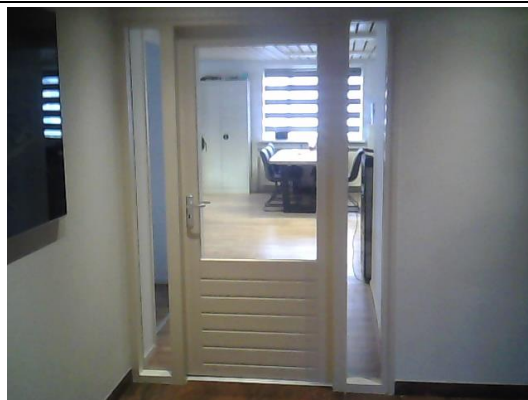
Binnenkozijnen met enkelglas, niet verdacht
