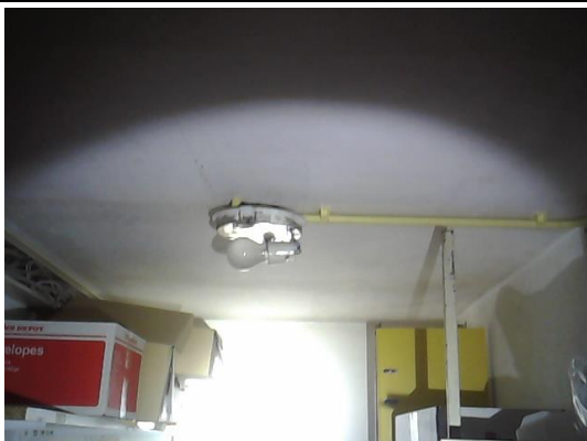
De overige plafonds zijn van beton, niet verdacht
