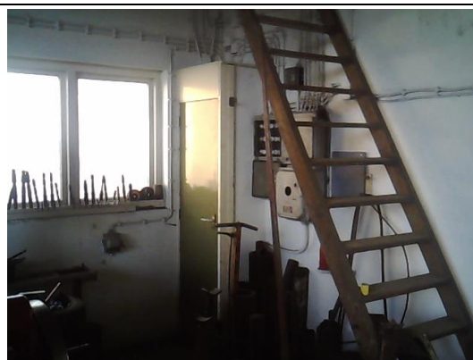
Inspectie van de meterkast ter plaatse van de werkplaats, geen verdachte materialen aangetroffen
