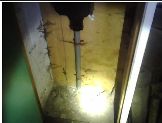
Inspectie van de binnenzijde van de meterkast ter plaatse van de werkplaats, geen verdachte materialen aangetroffen
