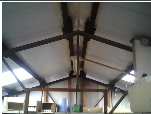
Dakconstructie met nieuwe damwand dakplaten, niet verdacht
