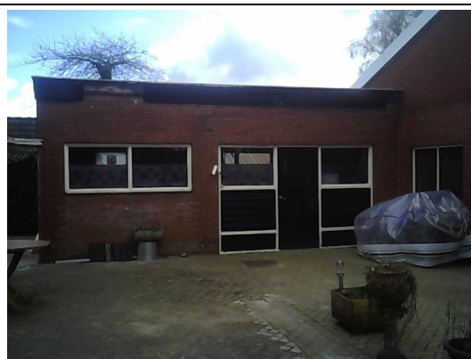
Aangrenzende schuur op perceel van de buren. Dit valt buiten de opdracht/onderzoeksgebied De beglazingskit in de kozijnen van de schuur valt buiten het onderzoeksgebied, zie materiaal buiten toepassingsgebied
