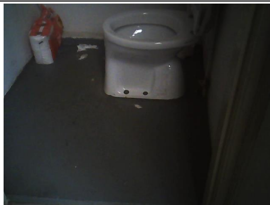
Riolering van de toilet en oude douche ter plaatse van de oude werkplaats, zie uitsluitingen
