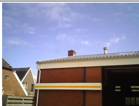
De schoorsteen boven het gemetselde rookkanaal is voorzien van gres buismateriaal, niet verdacht
