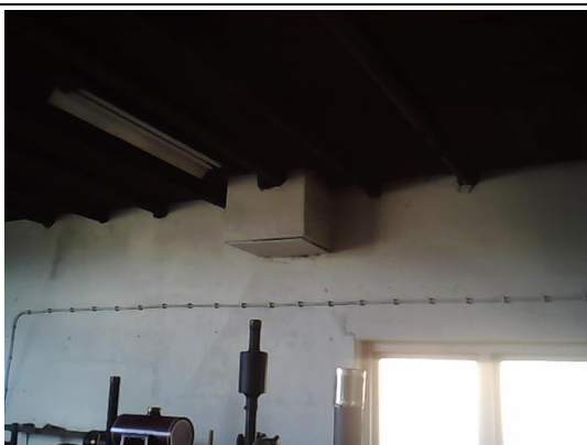
Onderzijde van een gemetseld rookkanaal ter plaatse van de werkplaats, geen verdachte materialen aangetroffen
