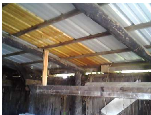
Inspectie aan binnenzijde van aanbouw, geen verdachte materialen aangetroffen
