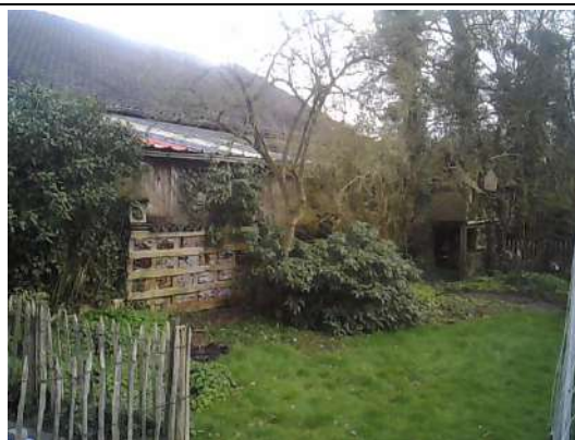
Inspectie van de buitenzijde van de aanbouw vanaf het perceel van nr. 5, geen verdachte materialen aangetroffen
