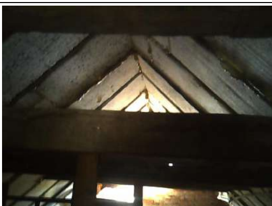
Inspectie op zolder van schuur 1, geen verdachte materialen aangetroffen
