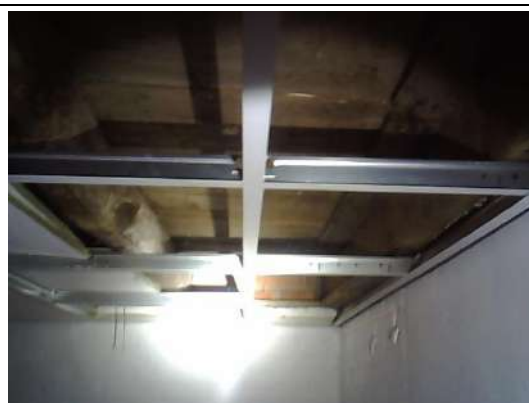
Inspectie va binnenzijde van schuur 2, geen verdachte materialen aangetroffen
