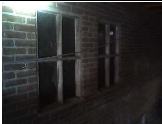
Betonnen kozijnen met stopverf in muur tussen schuur 2 en aanbouw, niet verdacht
