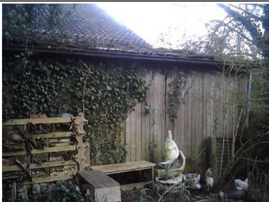
Inspectie van de buitenzijde van de aanbouw vanaf het perceel van nr. 5, geen verdachte materialen aangetroffen
