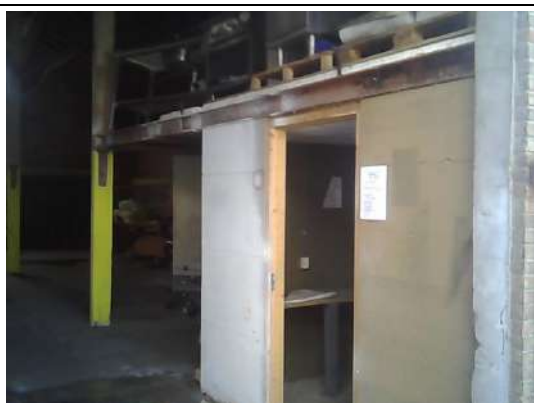
Inspectie va binnenzijde van schuur 2, geen verdachte materialen aangetroffen
