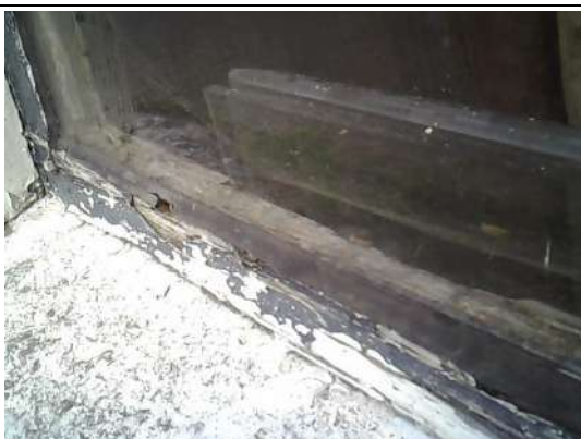
Kozijnen in buitengevel van schuur 1 met zachte beglazingskit, niet verdacht
