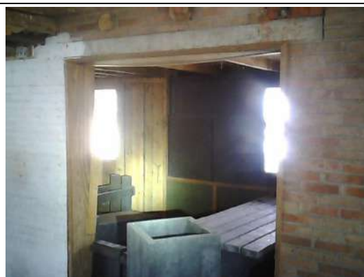
Inspectie aan binnenzijde van schuur 2, geen verdachte materialen aangetroffen
