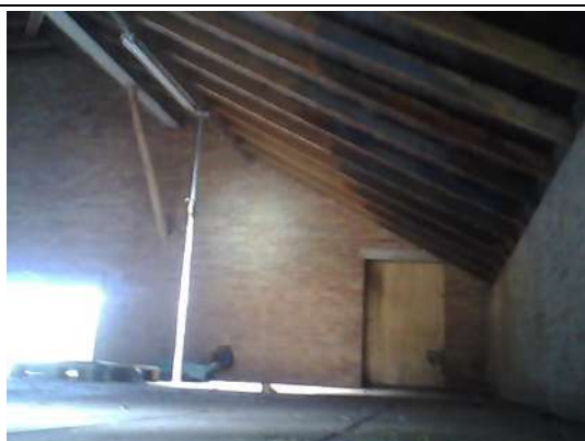
Inspectie aan binnenzijde van schuur 2, geen verdachte materialen aangetroffen
