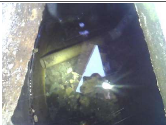
Inspectie van de waterput naast schuur 1, geen verdachte materialen aangetroffen
