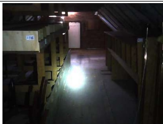
Inspectie op zolder van schuur 1, geen verdachte materialen aangetroffen
