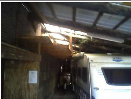
Inspectie aan binnenzijde van aanbouw, geen verdachte materialen aangetroffen
