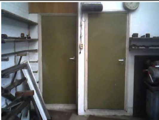
Voorzijde van oude douche en toilet ter plaatse van de werkplaats
