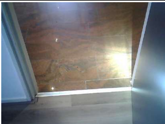
Inspectie van de vloeren in het kantoorgedeelte, geen verdachte materialen aangetroffen
