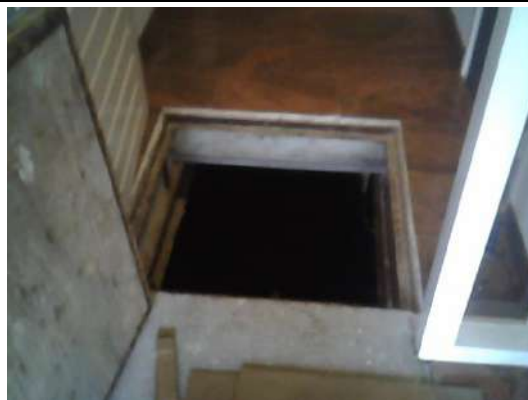
Inspectie van de vloer ter plaatse van het vloerluik, geen verdachte materialen aangetroffen
