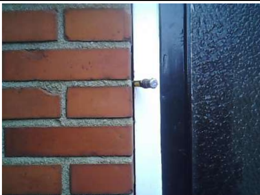
Inspectie van de spouwmuren, geen verdachte materialen aangetroffen
