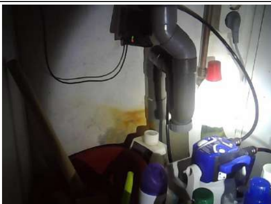
Inspectie achter keukenblok, geen verdachte materialen aangetroffen. Het verloop van de riolering is niet bekend geworden, zie uitsluitingen
