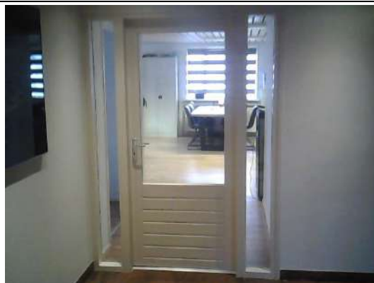
Binnenkozijnen met enkelglas, niet verdacht
