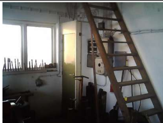
Inspectie van de meterkast ter plaatse van de werkplaats, geen verdachte materialen aangetroffen
