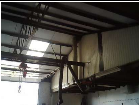
Dakconstructie met nieuwe damwand dakplaten, niet verdacht
