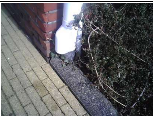
De hemelwaterafvoeren zijn van pvc
