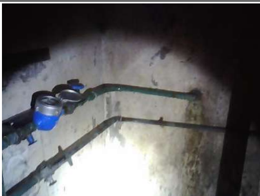
Inspectie in de ruime watermeterput, geen verdachte materialen aangetroffen
