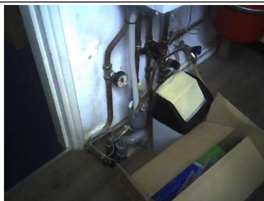
Leidingwerk onder cv-ketel, geen verdachte materialen aangetroffen
