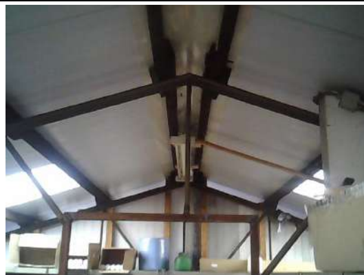
Dakconstructie met nieuwe damwand dakplaten, niet verdacht
