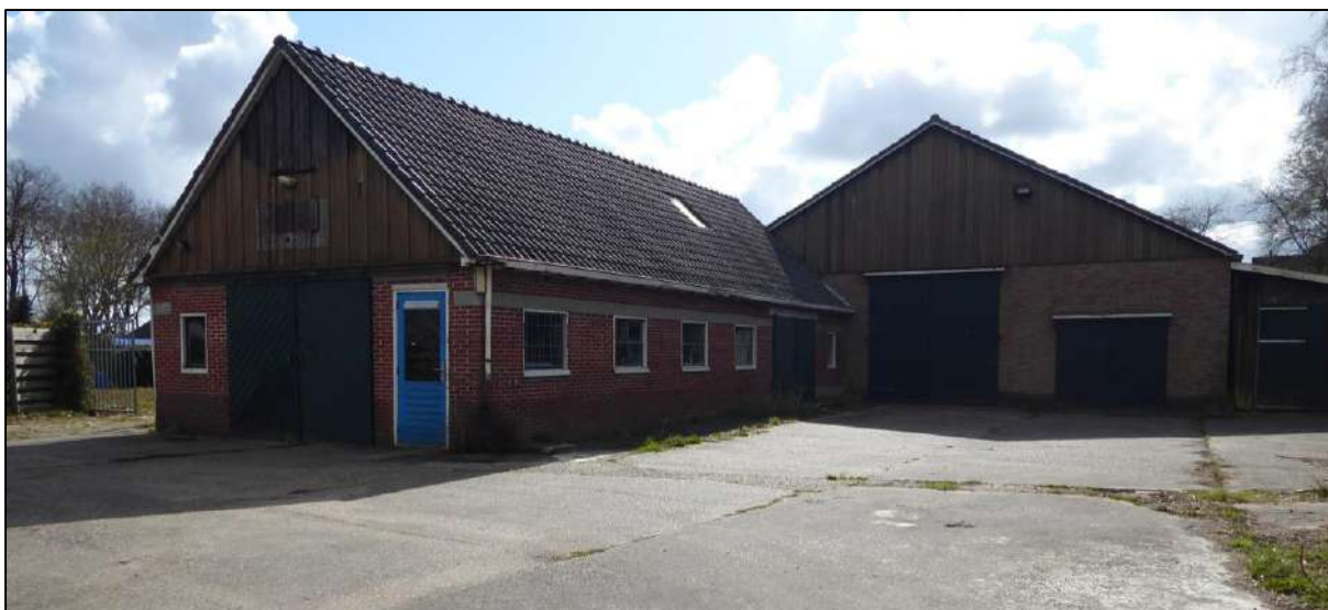
Figuur 1.3. De bebouwing van stationsstraat 3a (deelgebied 2).
