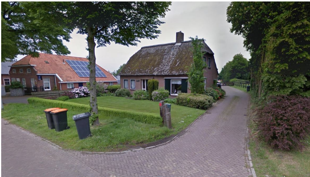
Bestaande bedrijfswoning Bonnen 19 (bron: Google Streetview)
