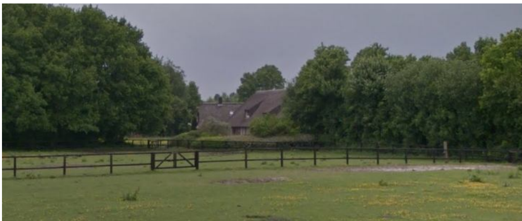
Bestaande paardenshuur met daarvoor de bestaande bedrijfswoning Bonnen 19 gezien vanaf de Hondsrugweg (bron: Google Streetview)
