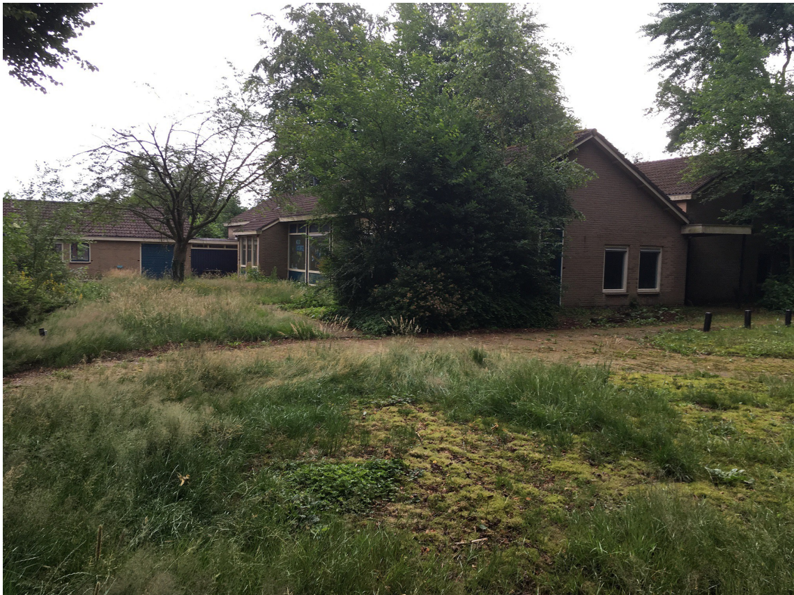
Figuur 8. Gieten, Naweg: Foto van het plangebied, genomen richting het noordoosten. Het plangebied bestaat voornamelijk uit het te slopen groene kruis gebouw en de tuin eromheen.
