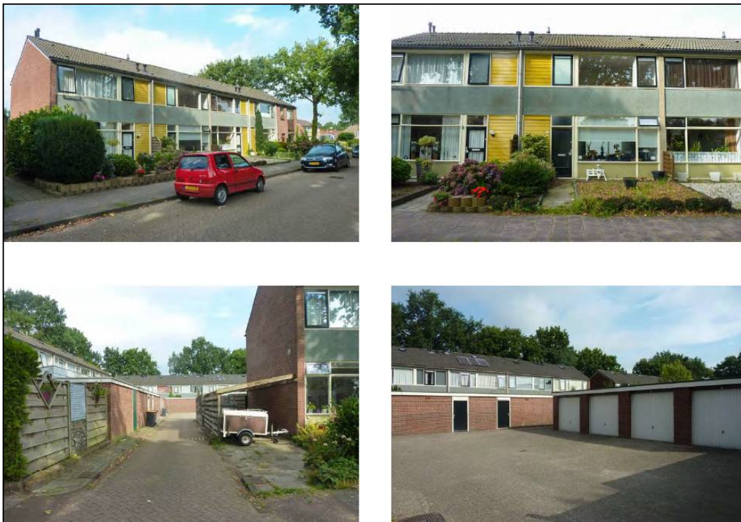
Bestaande woningen aan de Markescheiding en Kerspelstraat met binnenterrein met garageboxen in deelgebied C (bron: KAW)
