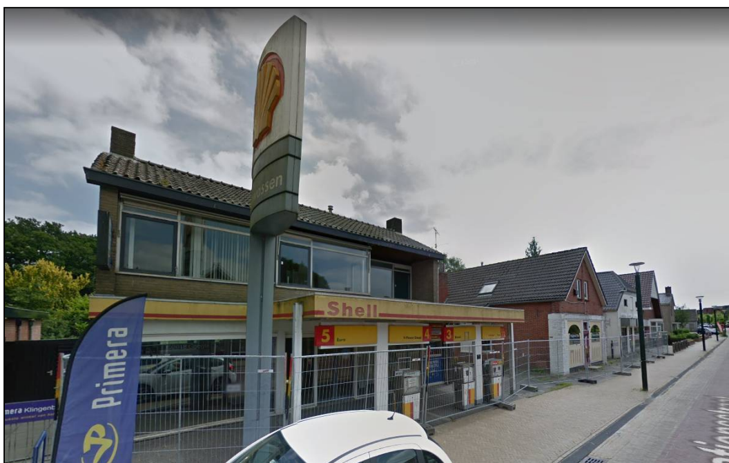
Situatie plangebied aan de Stationsstraat voor de sloop, gezien vanuit het noorden (bron: Google Streetview)
