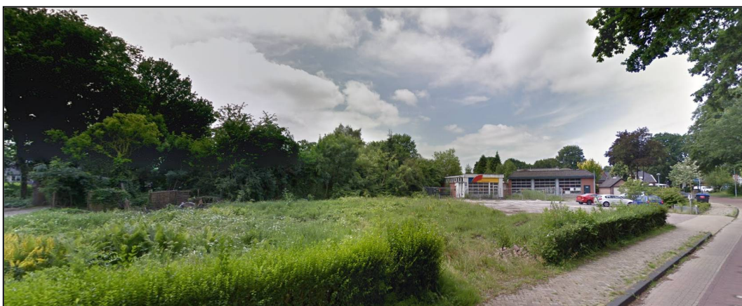
Situatie plangebied aan de Boddeveld voor de sloop (bron: Google Streetview)
