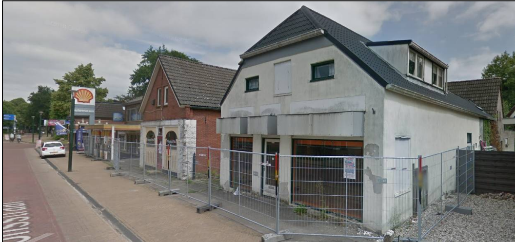
Situatie plangebied aan de Stationsstraat voor de sloop, gezien vanuit het zuiden (bron: Google Streetview)
