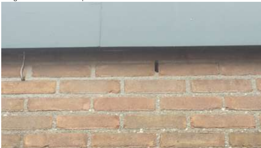
Figuur 4.1 Open stootvoeg in de spouwmuur. Foto: Erwin Goutbeek, Ecogroen.
