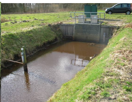
Figuur 2. Gemaal Gasselternijveen (KGM-H-16640)
