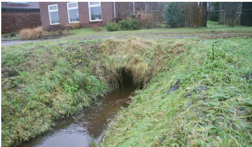
Figuur 2. Uitstroomopening Boerdijk lange duiker Cholerasloot.
