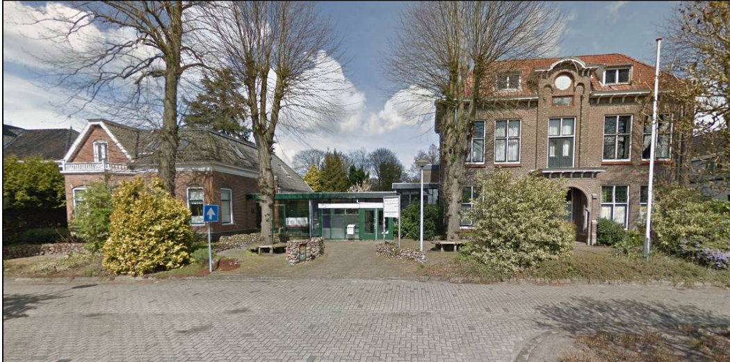
Bestaande situatie, v.l.n.r.: woning Vaart 7 – het verbindende gebouw – voormalig gemeentehuis Vaart 11 (bron: Google Streetview)
