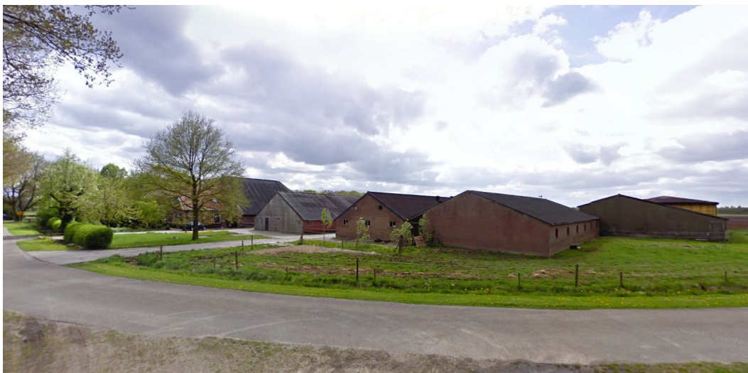
De voormalige geitenboerderij op het perceel Vredenheimseweg 1 voor de sloop van de bedrijfsbebouwing, uiterst links de voormalige bedrijfswoning (bron: Google Streetview)
