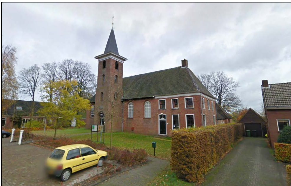
Figuur 3. Aanzicht op het kerkgebouw
