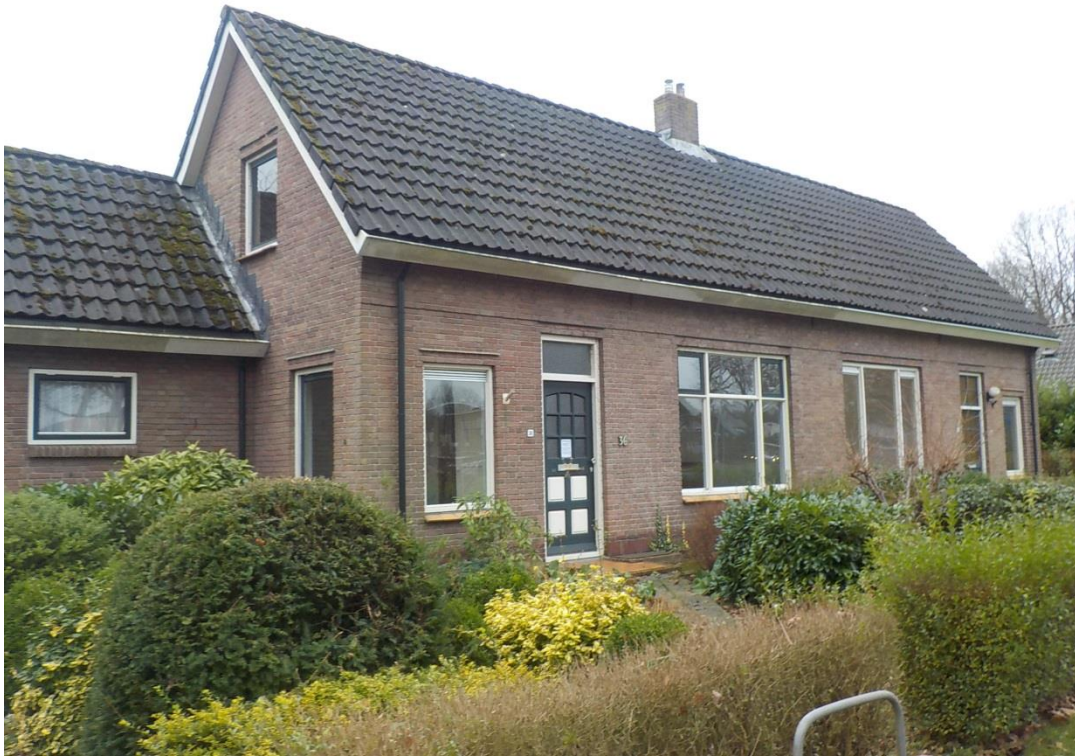
Foto 1 De 2 onder 1 kapwoningen die gesloopt gaan worden.
