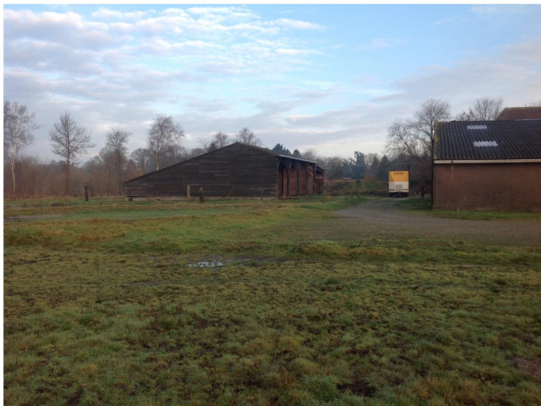
Afbeelding 10: Foto van de westzijde van het plangebied richting het noorden.
