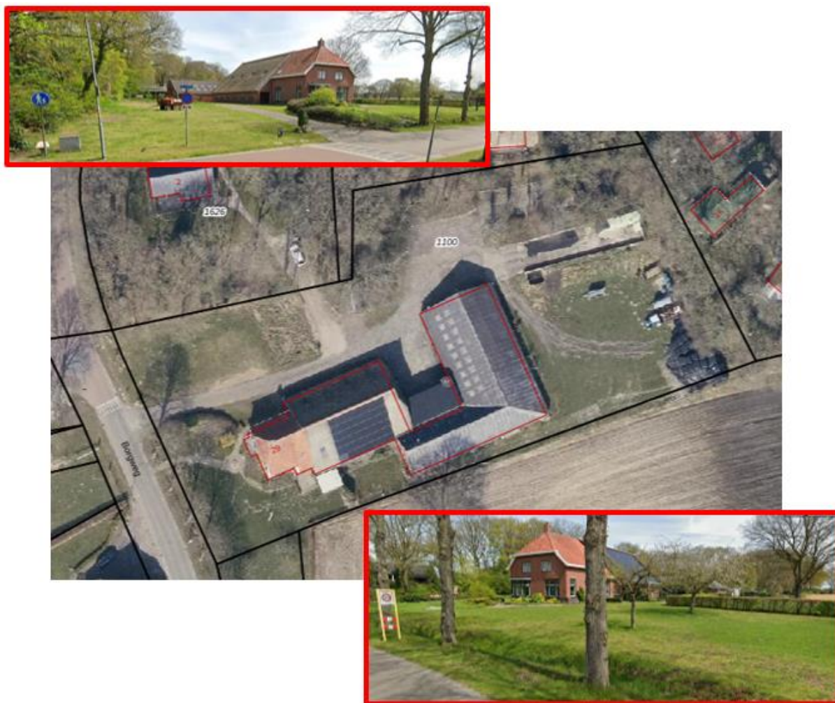
Figuur 4: huidig aanzicht vanaf de Borgweg op het perceel Borgweg 29 te Schipborg
