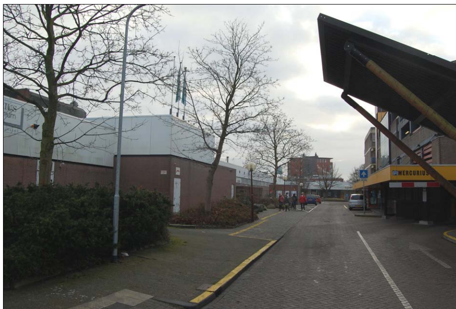
Bestaande situatie bevoorradingsstraat, gezien vanaf de Minervalaan
