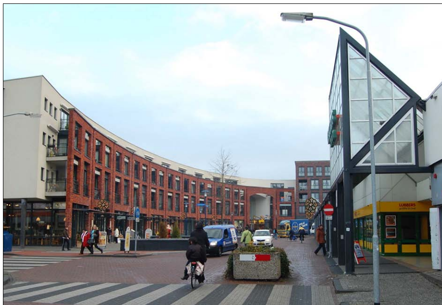
Tegenover de gebogen lijn van Triade komt de nieuwe, strakke gevel van het Mercuriuscentrum
