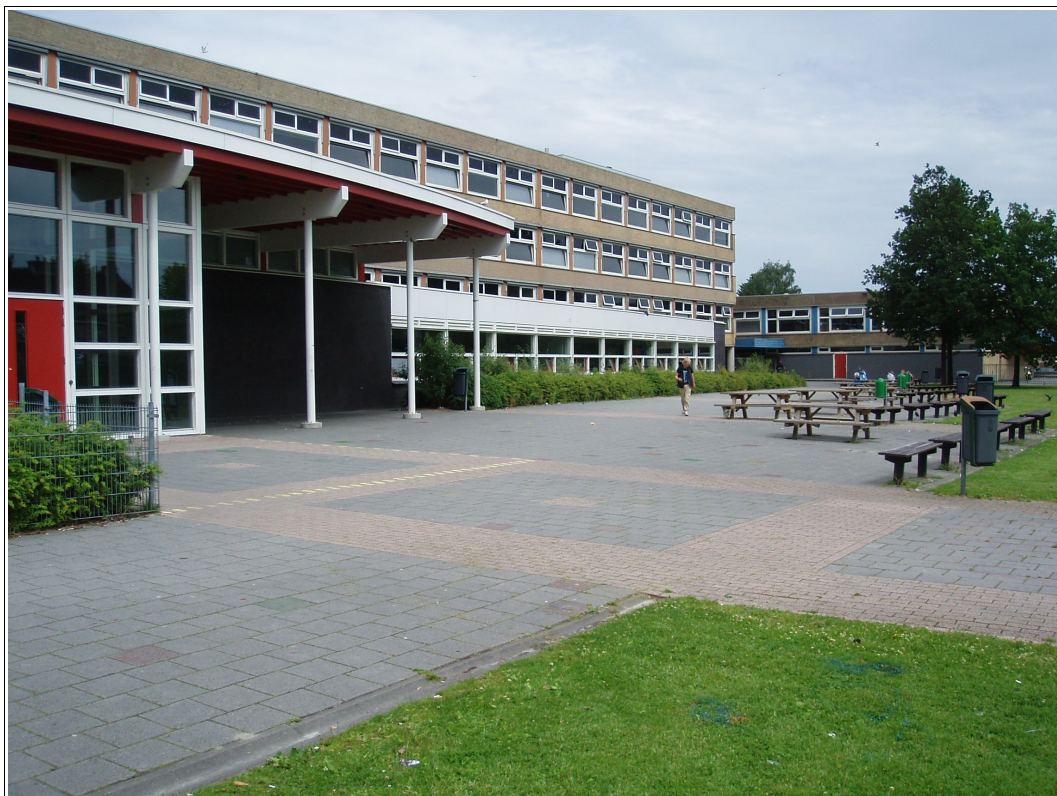
Figuur 2: Assen, Groen van Prinstererlaan 98: Foto genomen in noordoostelijke richting.
