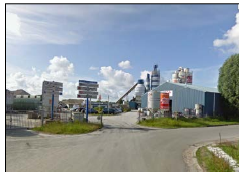
Betonmortelcentrale MIA aan de Wenkebachstraat
