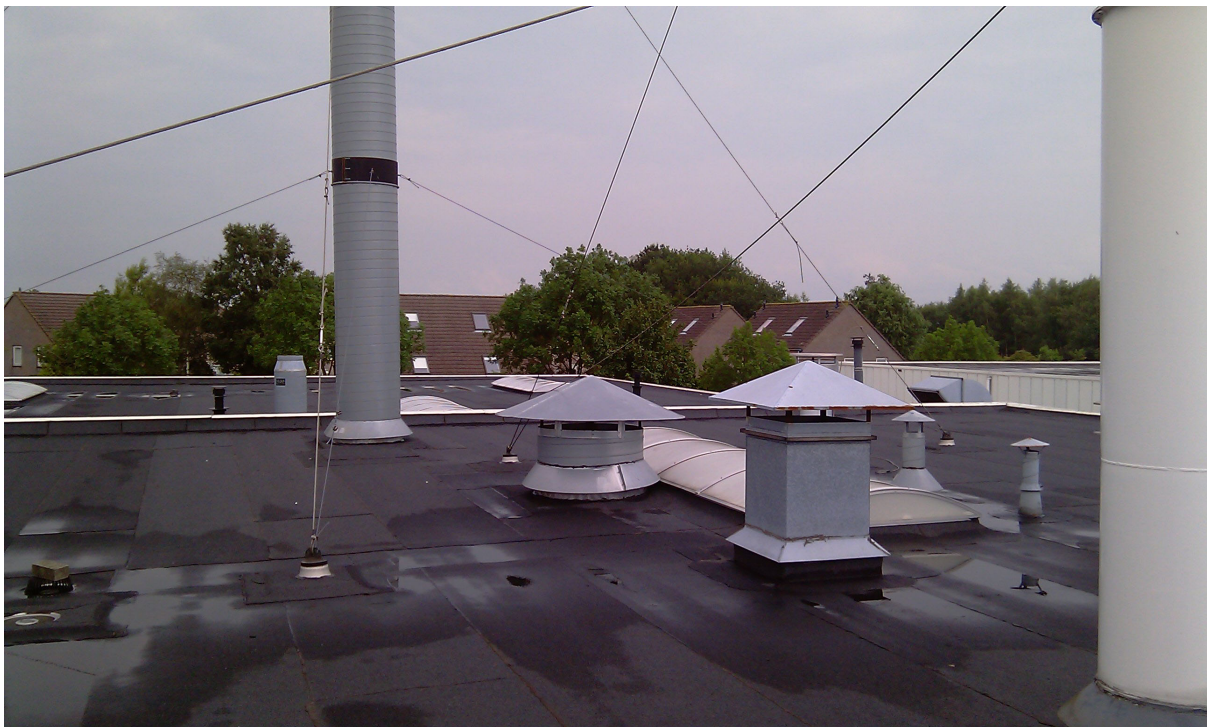
Afbeelding 4.1: situatie dak spuiterij met afzuigingen
